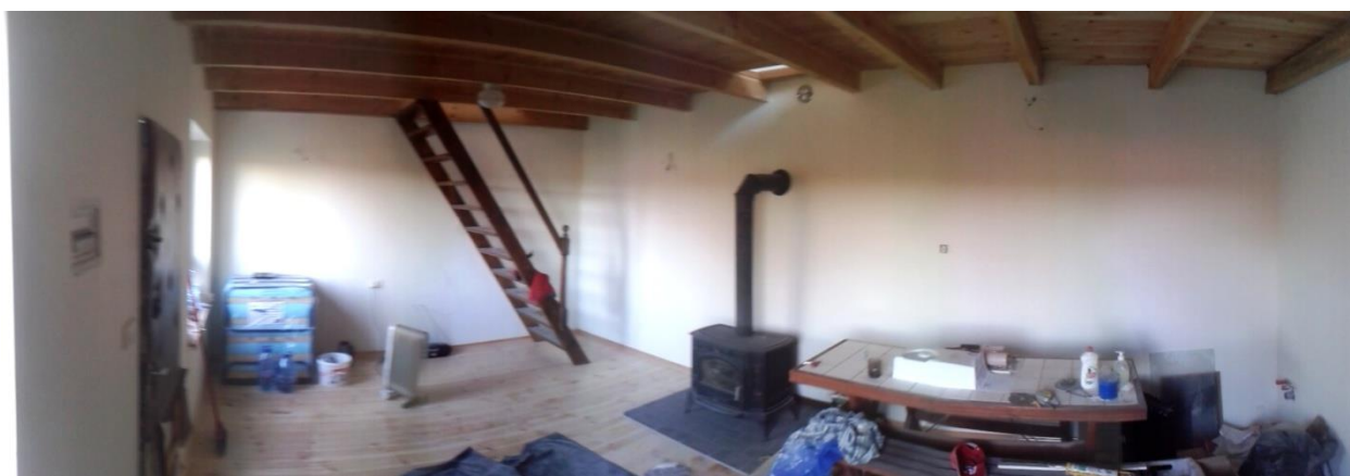
Fot. Co prawda jeszcze mały nieporządek ale już widać efekty pracy. Pomieszczenie na parterze powstałe po wyburzeniu komina i ścianki działowej
